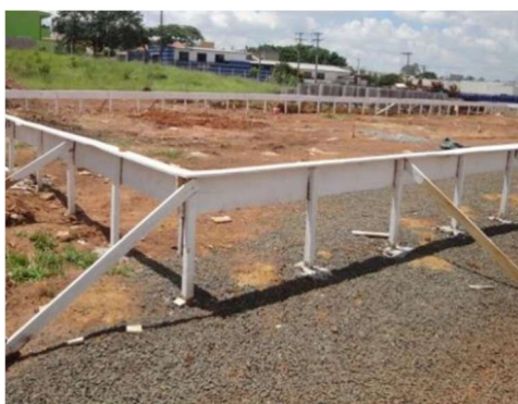
Gabarito de tábuas corridas pontaletadas, com travamento
