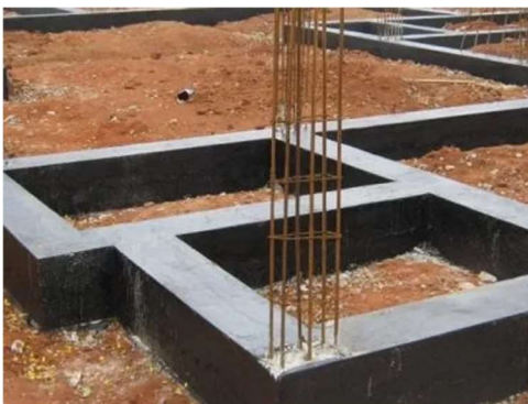
Impermeabilização de baldrame
