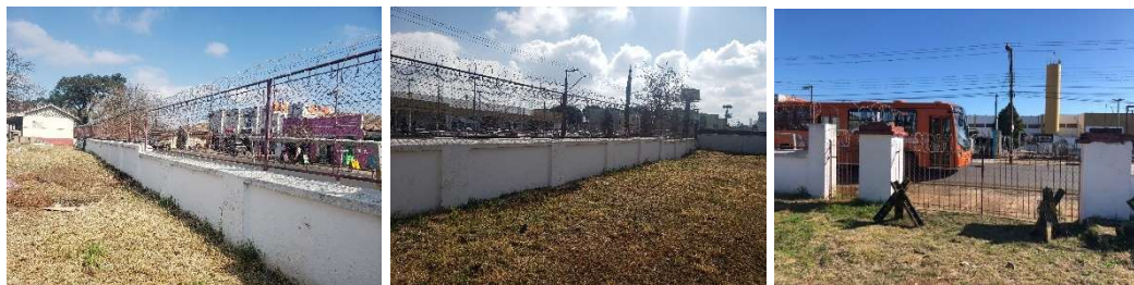
Muro a ser demolido
