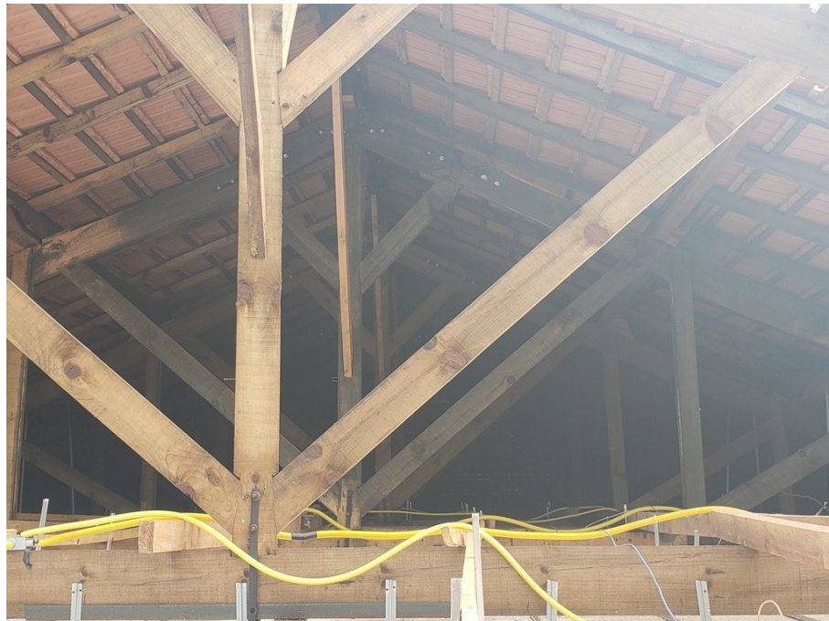
Intervenções externas – Troca da estrutura com reaproveitamento das telhas francesas
