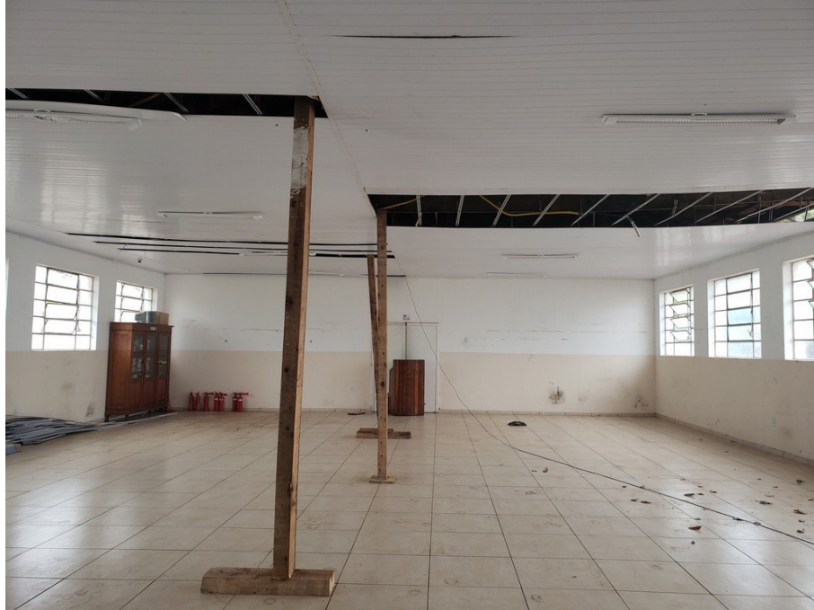
Intervenções internas – Troca de forro de PVC e pintura das paredes
